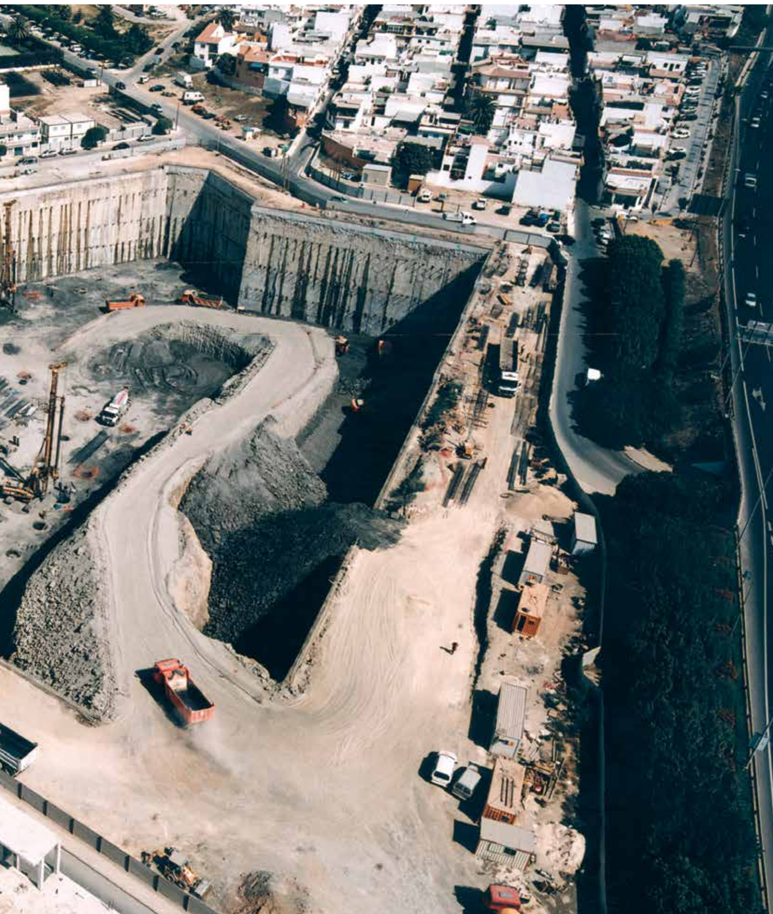
Hipercor de Mijas Costa, Mijas, Málaga Muro Pantalla Anclado y Auscultación Consistente en Inclínómetros
