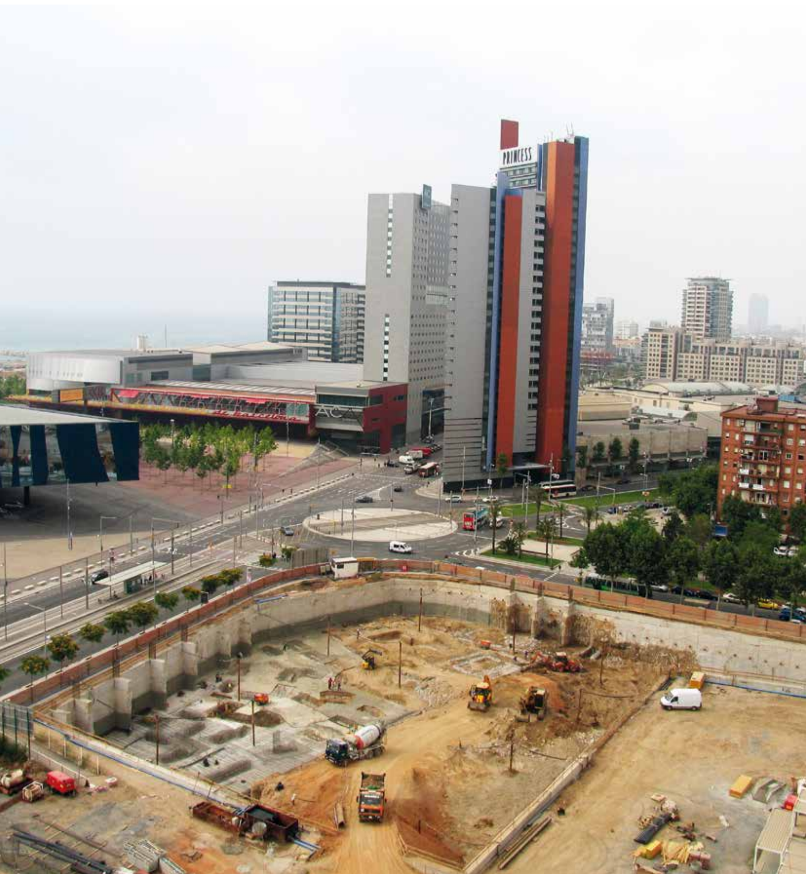
Diagonal 0 Rambla Prim Passeig Taulat-1, Barcelona Muro Pantalla
