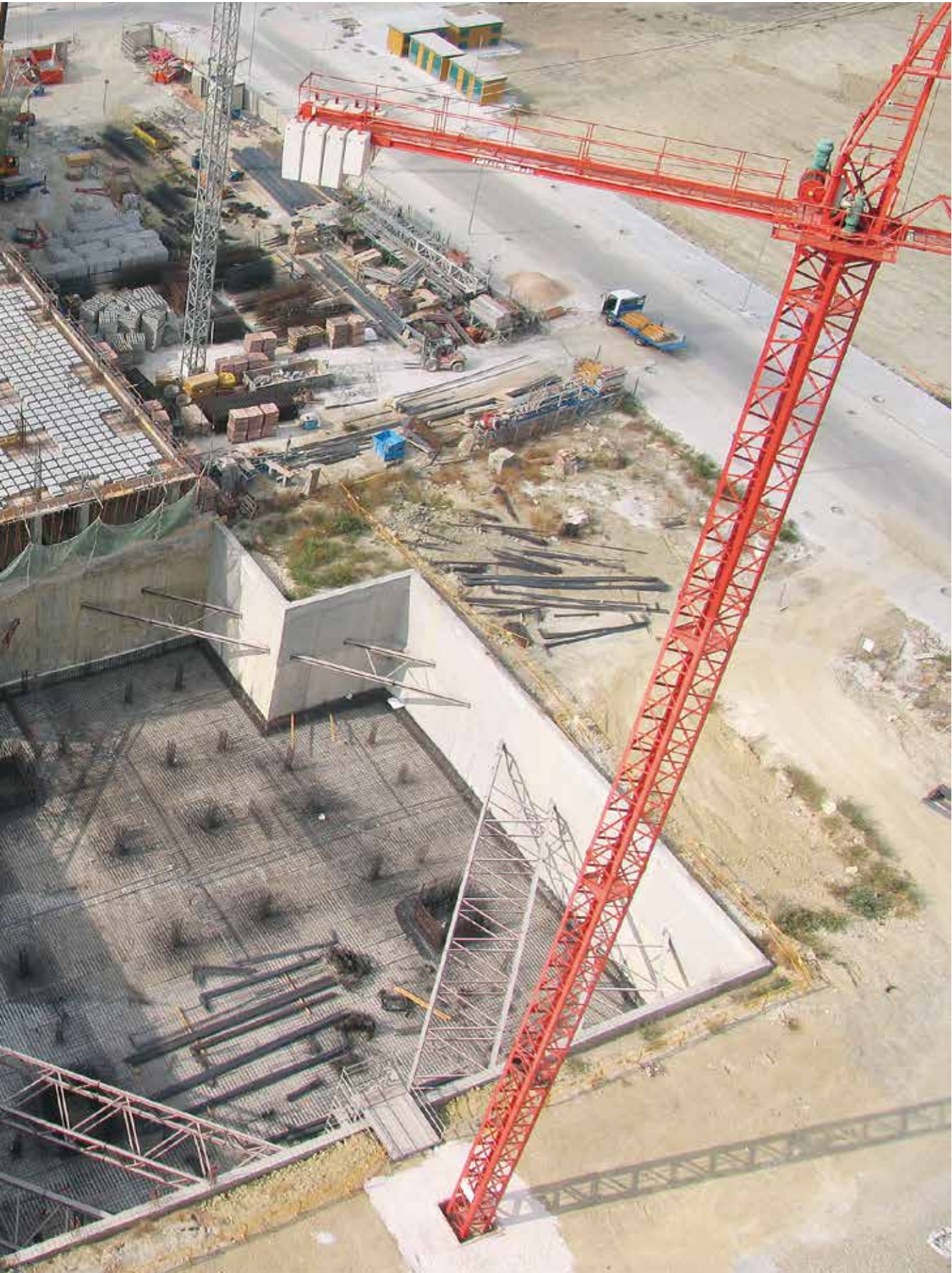
Viviendas las Morillas Parcela RP 5C, Málaga Muro Pantalla
