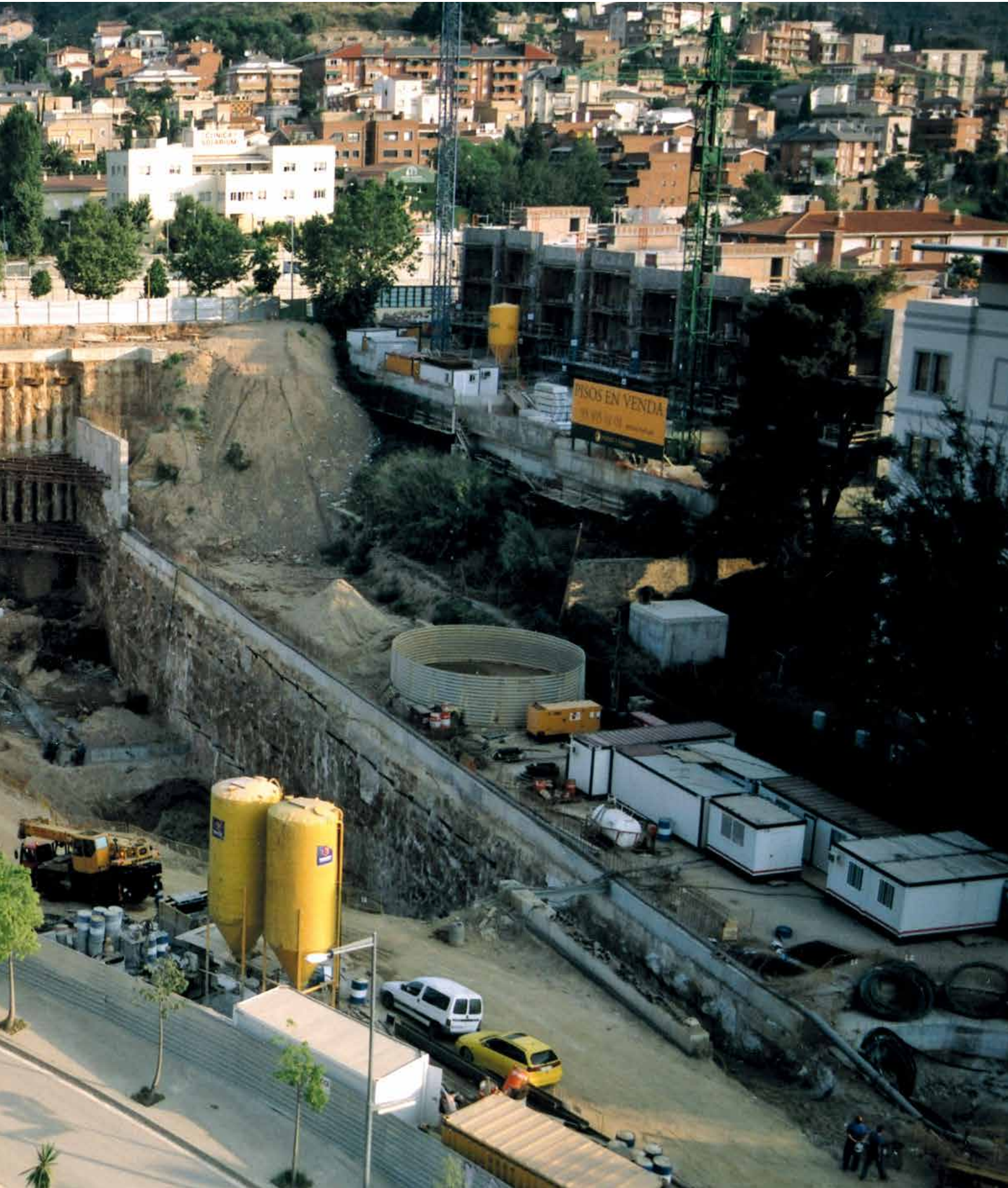
Clínica Quirón, Plaza Alfonso Comín, Barcelona Muro Pantalla, Pilotes y Anclajes
