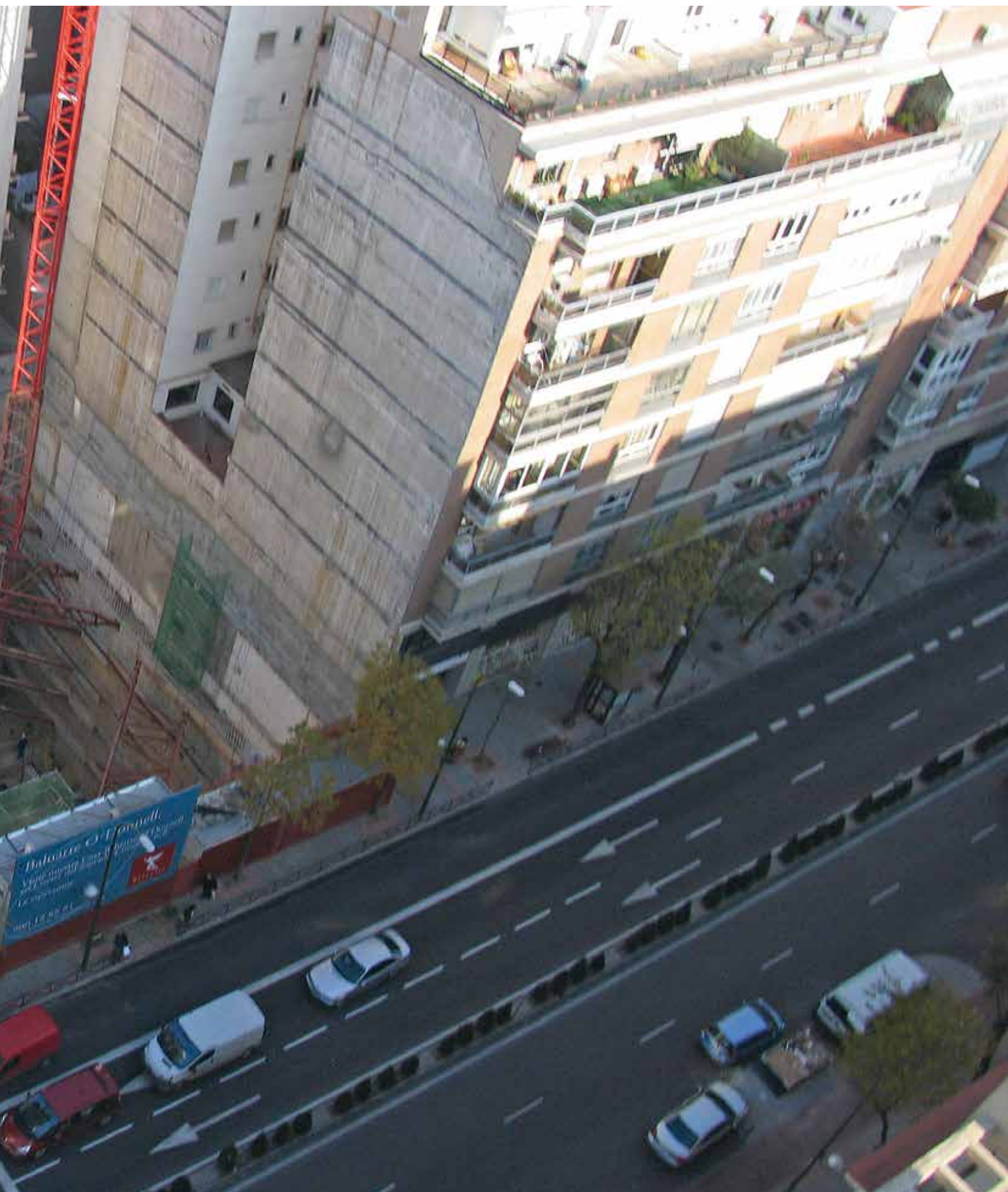
Edificio de Viviendas en la Calle O'Donnell, 17 Muro Pantalla
