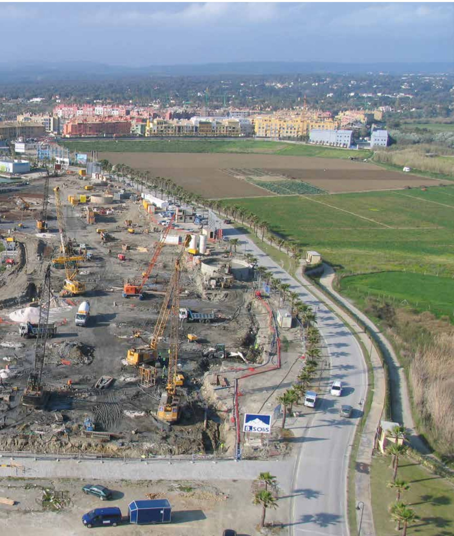
Edificio Residencial Ribera del Marlin Parcela 5-6 P2. Sotogrande, Cádiz Construcción Drenaje y Rebajamiento del Nivel Freático, Modulos Pantalla, Pantallas de Hormigón Armado
