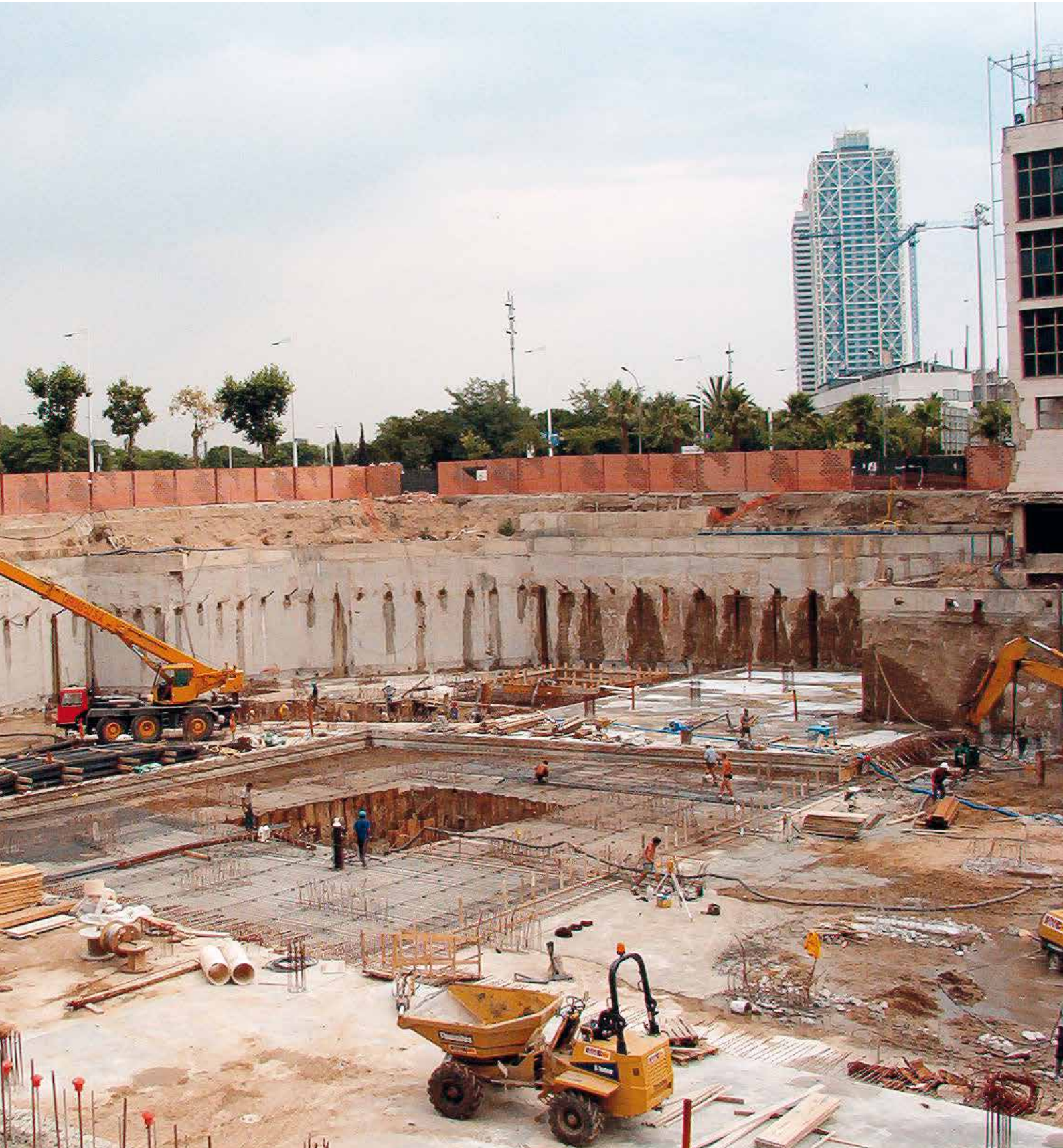
Edificio Gas Natural, Barcelona Muro Pantalla y Anclajes
