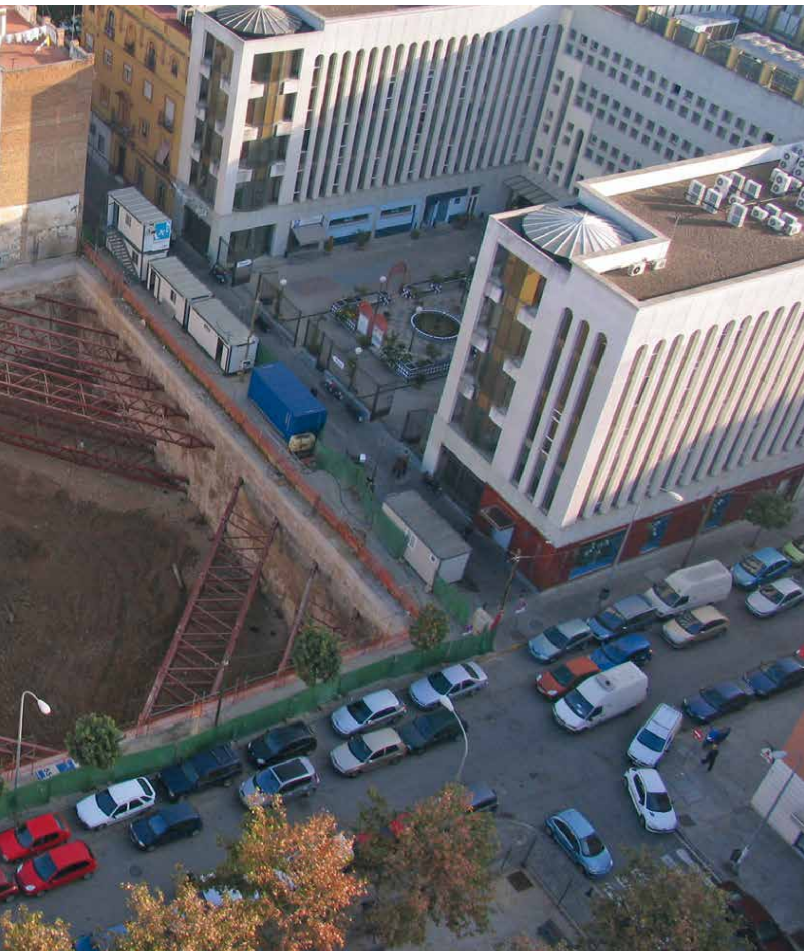
Viviendas Calle Blanco White, Sevilla Muro Pantalla
