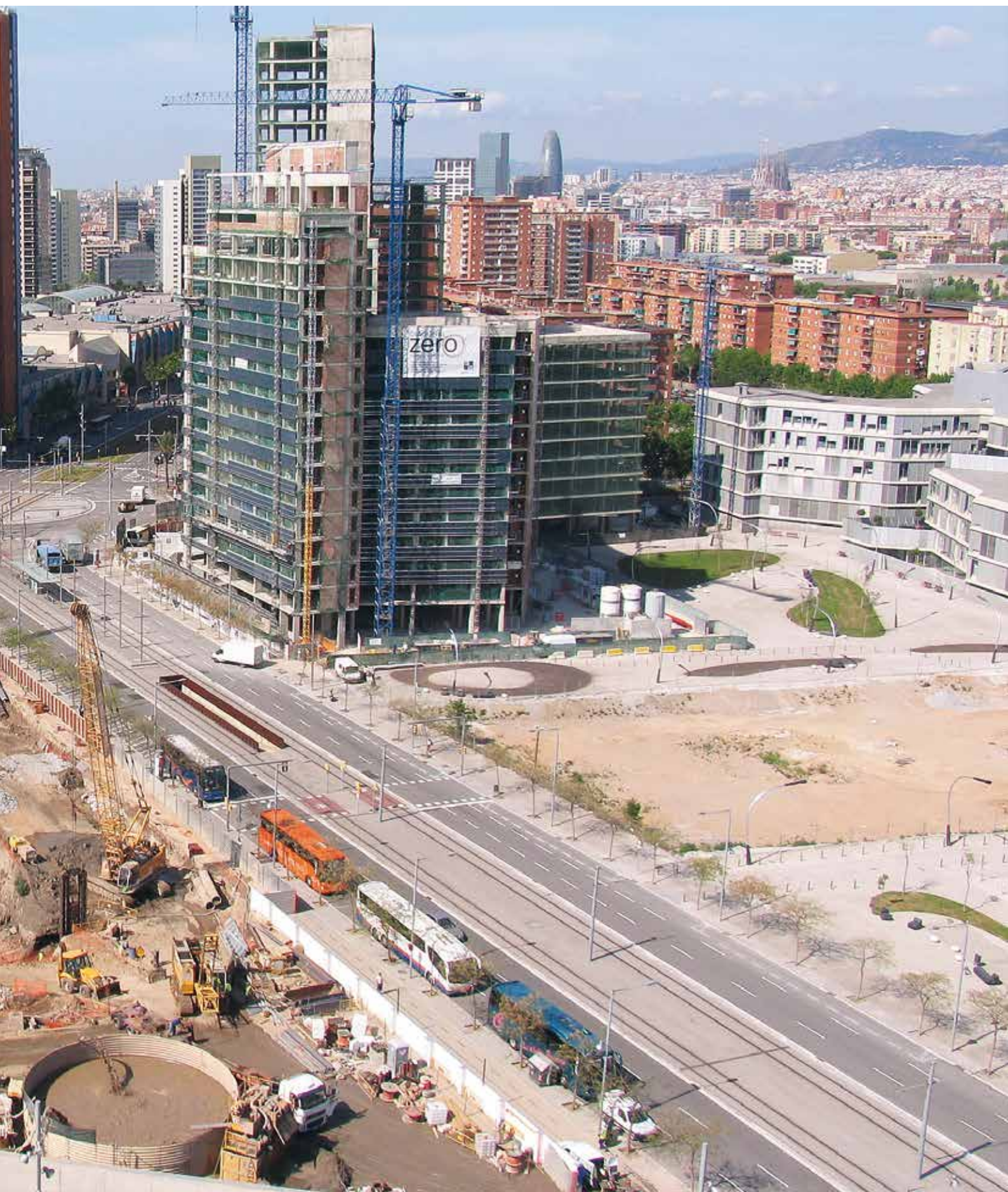
Edificio Torre Diagonal 0, Barcelona Muro Pantalla
