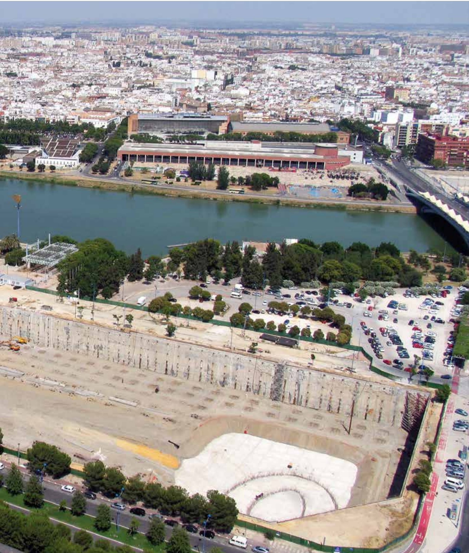
Centro de Servicios Terciarios "Puerto Triana" Isla de la Cartuja, Sevilla Muro Pantalla, Anclajes, Elementos Portantes y Pilotes Prefabricados
